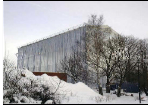
Figur 11 Ett väderskydd av typen tillfällig produktionshall där ett flerfamiljshus byggs upp.
