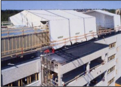
Figur 10 En tillfällig produktionshall har spänts upp och skyddar underliggande konstruktioner.
